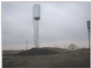
Водонапорная башня с. Александровка
