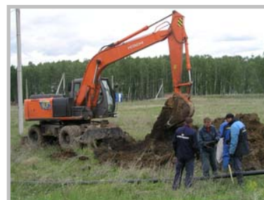
Строительство межпоселкового газопровода к с. Пришиб
