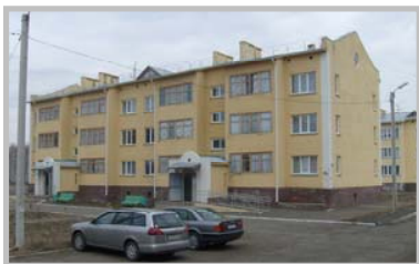
Многоэтажные дома нового микрорайона в с.Азово
