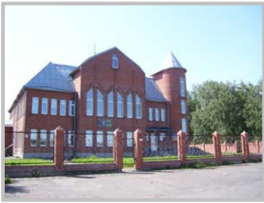
Здание электросвязи, с. Азово
