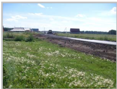
Строительство межпоселковой дороги Сосновка-Новинка
